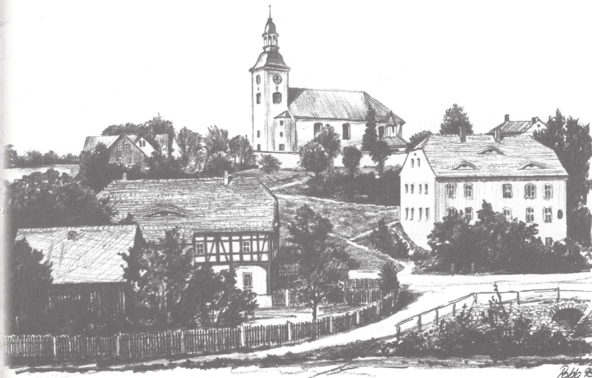
Václavický kostel – bývalá dominanta obce
